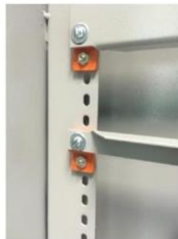
Figura 2: Detalhe da longarina e aplicação dos isoladores
