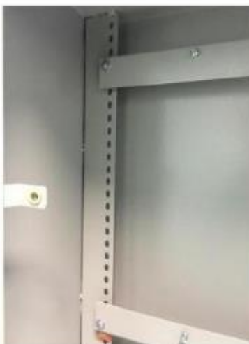
Figura 2: Detalhe da longarina e aplicação dos isoladores
